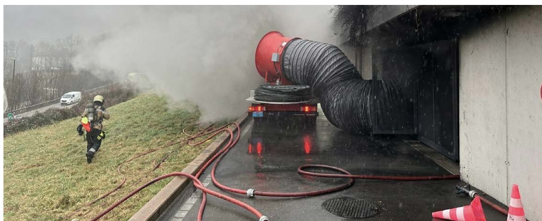
Brand Autoeinstellhalle in Aesch, 18.01.2024
